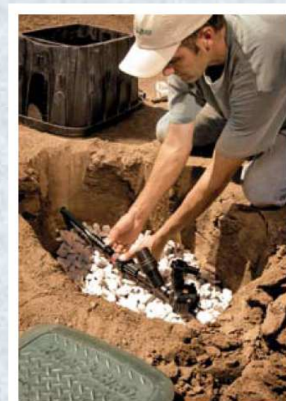
Instalación de arquetas
